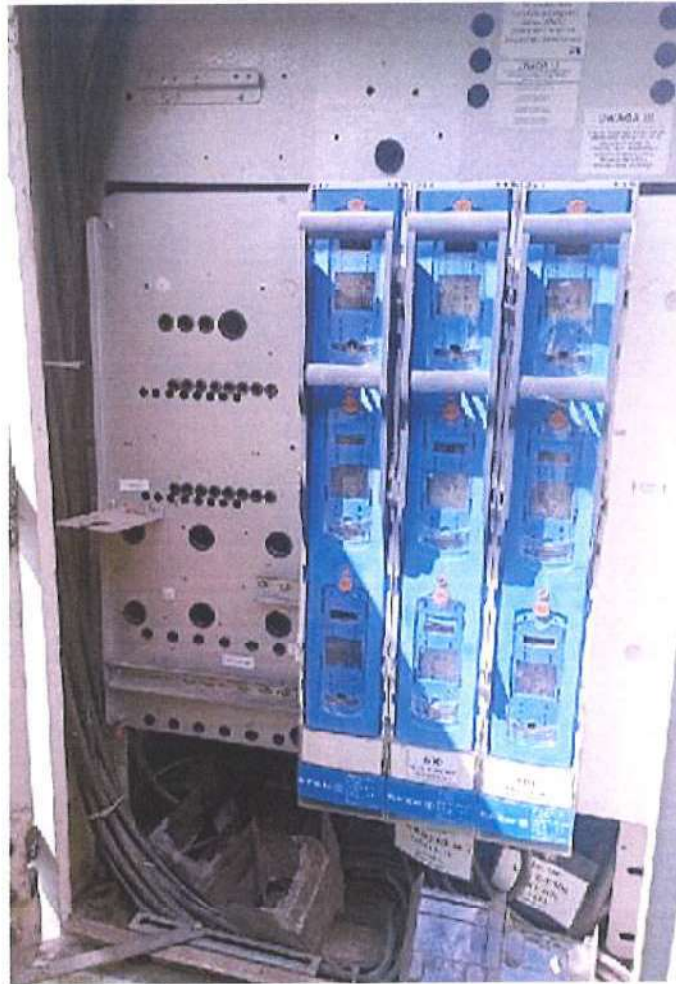
Rozdzielnic stacyjna po wyniesieniu układu AMI
